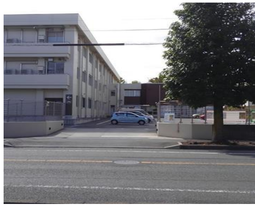
④そあら 駐車場出入口
